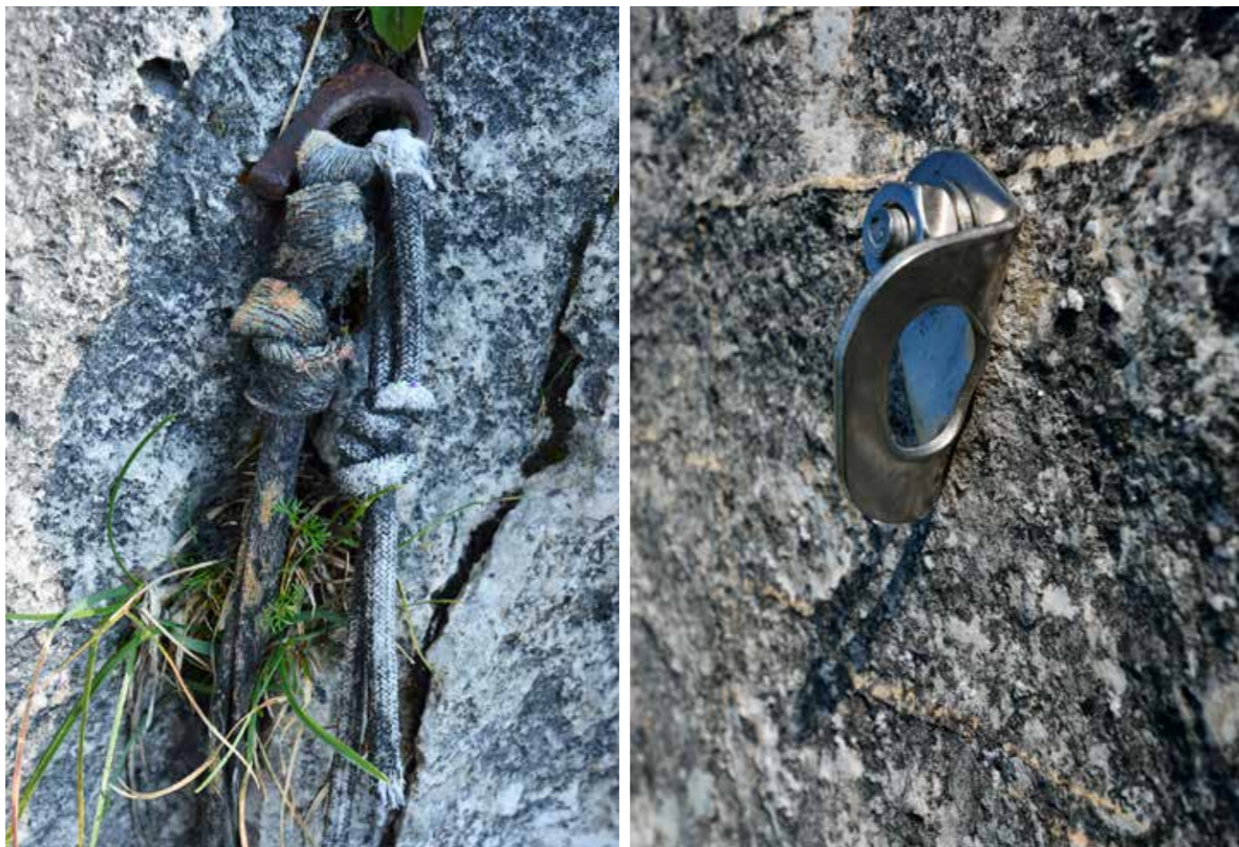
Wem würde man seine Sicherheit lieber anvertrauen – einem von den Erstbegehern geschlagenen Normalhaken, der vielleicht von unten angerostet ist (links, im Bockmattli-Gebiet), oder einem modernen Bohrhaken?
